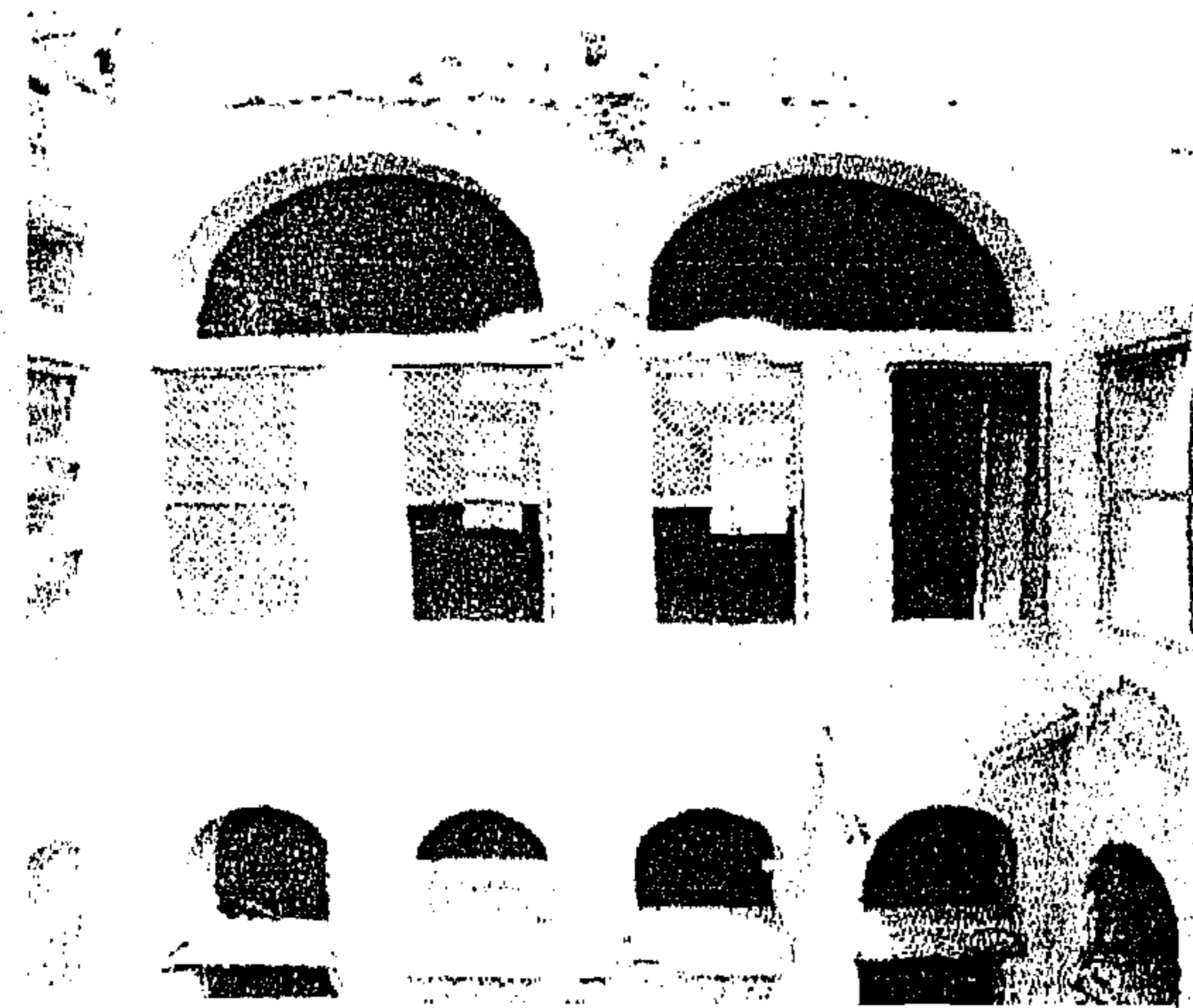
طرق الانشاء التقليدية المحلية للانشاء مثل طريقة بناء القبة و العقود الدائرية
